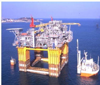
FPU (Floating Production Unit)
